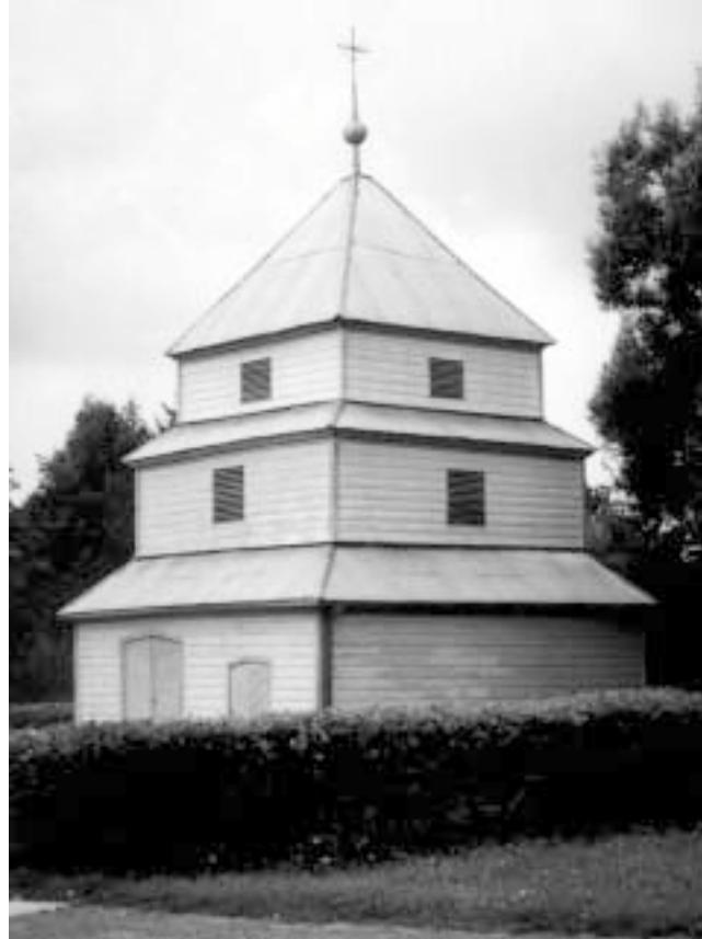
varpinė daug kartų atnaujinta, remontuota. Vienas iš reikšmingų remontų įvyko 1953 m. Tada iš trijų pusų sumūryti nauji pamatai, sutvirtintos pakrypusios sienos, pakeistos durys, apatinis tarpsnis apkaltas horizontaliomis lentomis (41). Anksčiau varpinė, kaip ir bažnyčia, buvo apkalta vertikaliai. Vidurinis bei viršutinis tarpsniai iki paskutinio XX a. dešimtmečio išliko apkalti stačiomis lentomis.
